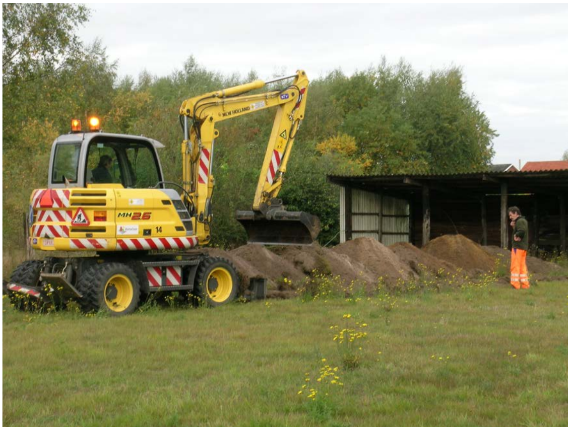
Fig 4: Aanleggen van sleuf 1 met de bandenkraan
